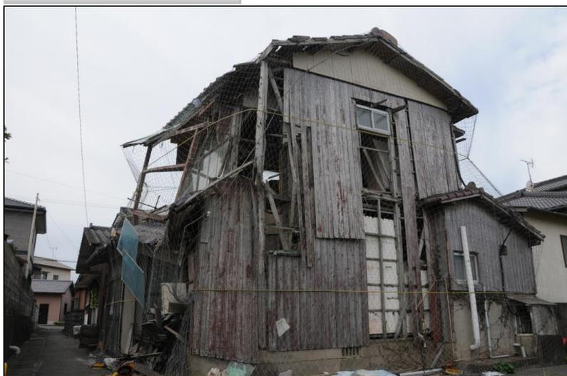
隣家への倒壊や通行人への被害を防ぐために、緊急的措置として、市が空き家全体をネットで覆っていた（平成26年12月）
